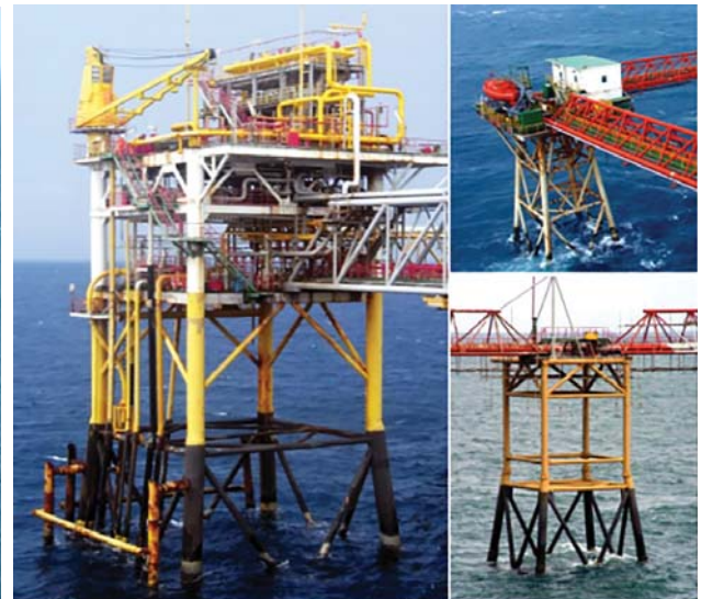
(d) Giàn ống đứng, giàn cầu dẫn
