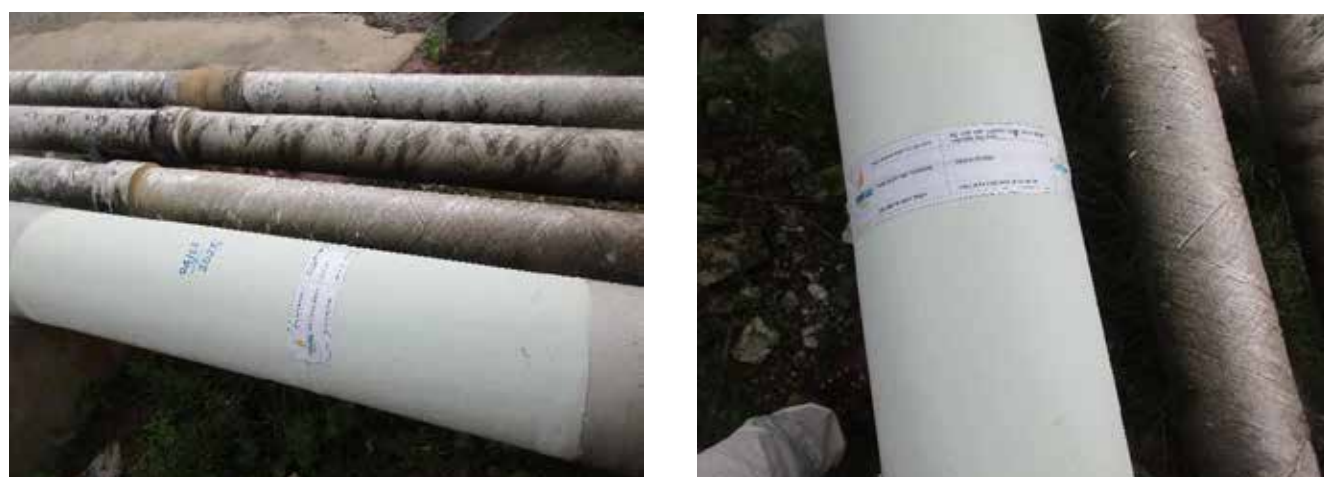
Hình 11. Kết quả thử nghiệm lớp phủ epoxy thông minh tại khu vực đường ống công nghệ U34 (VT2) của Nhà máy Lọc dầu Dung Quất sau 8 tháng.
